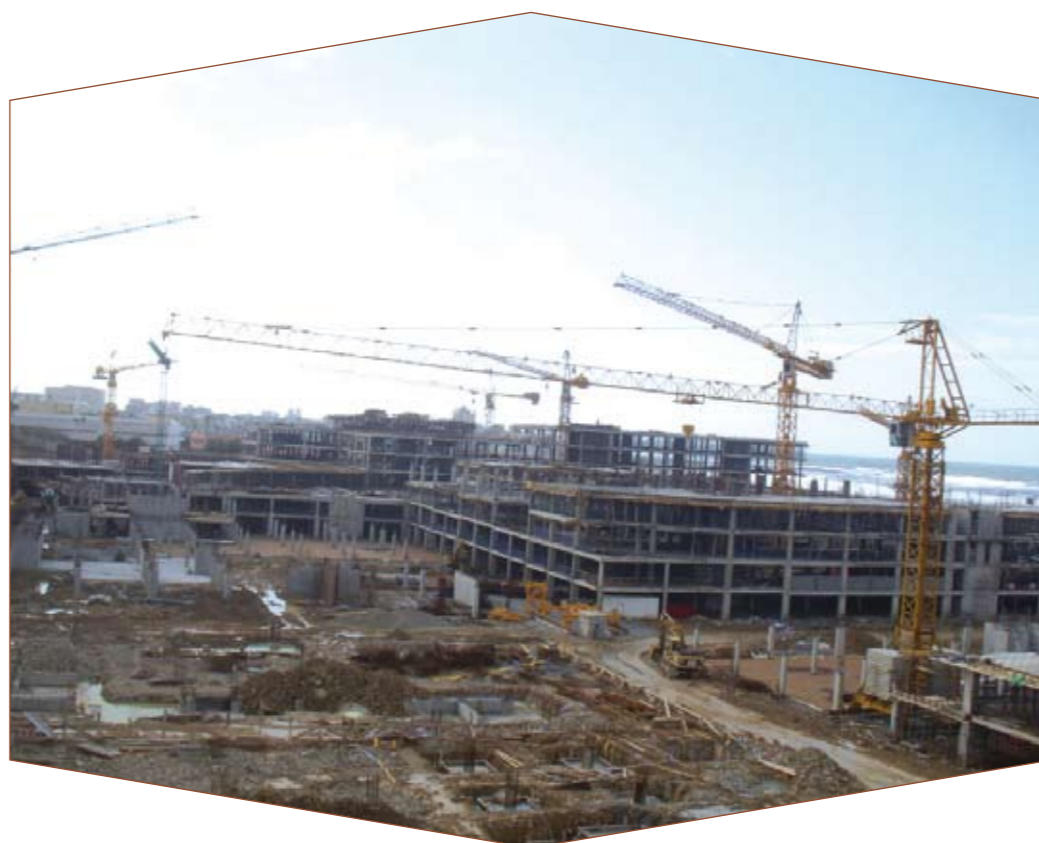
Ici, les travaux de gros œuvre du projet Anfa Place.
