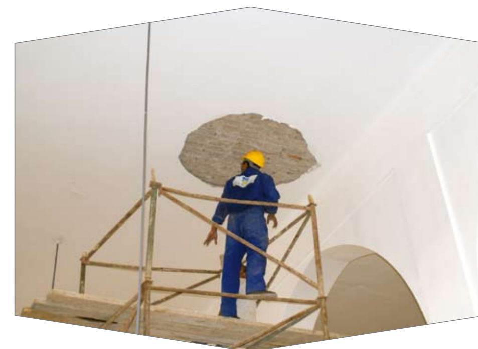
Ici réfection de la toiture d'une mosquée.
