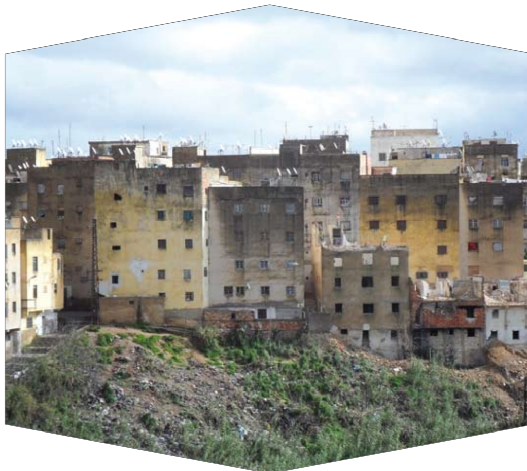
Quelques constructions menaçant ruine recensées à Jnanates à Fès.
