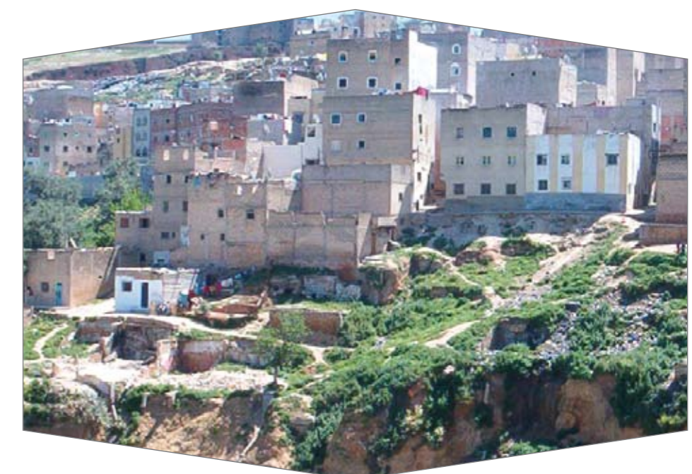
Habitations menaçant ruine construites sur des terrains accidentés.
