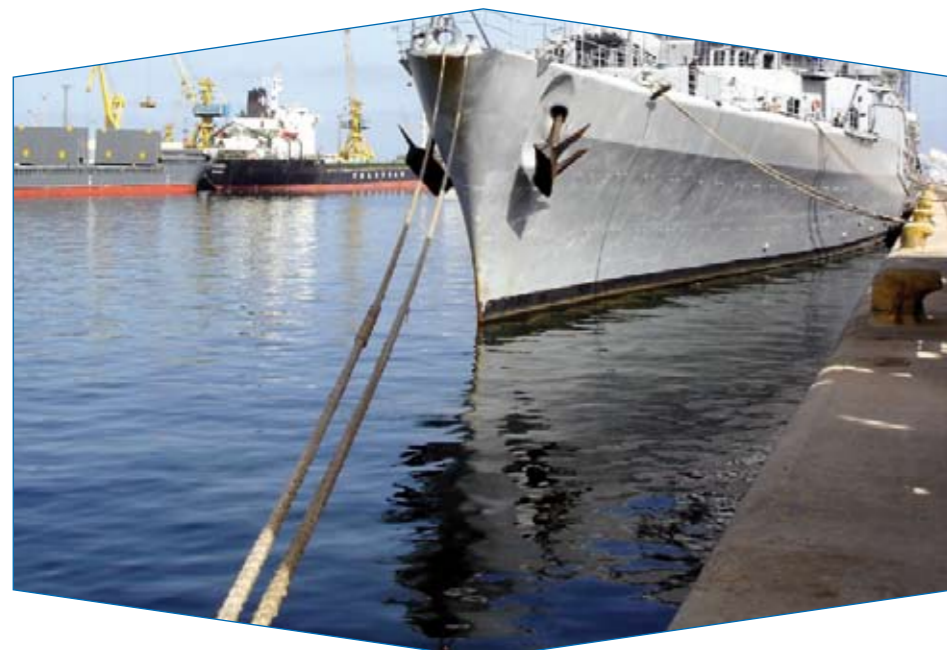
La plupart des bollards des quais diagnostiqués présentent des corrosions de leur armature.
